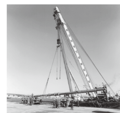
ネジ支柱のトレーラーへの積み込み
