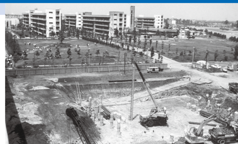
くい打ち(昭和49年4月)
